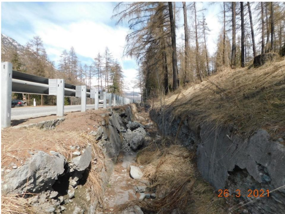
**Figura 4.4: Canale in calcestruzzo da demolire e ricostruire**
