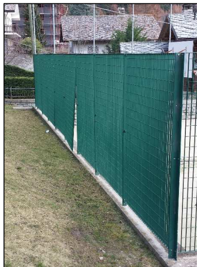
Situazione di degrado della recinzione esistente e delle canalette di scolo delle acque.
