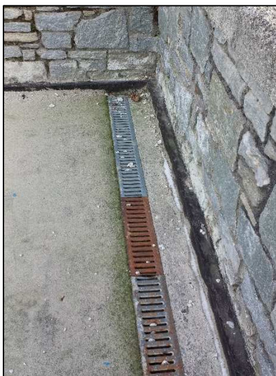
Situazione di degrado della recinzione esistente e delle canalette di scolo delle acque.
